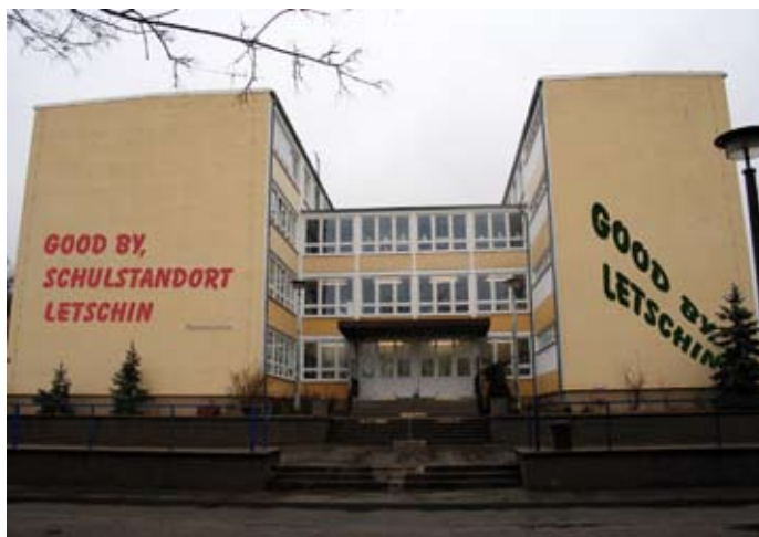
Genau 60 Jahre nach ihrer Einweihung wird die Letschiner Oberschule geschlossen. Die 1975 als POS gegründete Schule, die zeitweise auch mit einer Gymnasialen Oberstufe arbeitete, war nach der Schließung von Golzow die letzte Oberschule in ländlichen Oderbruch.
